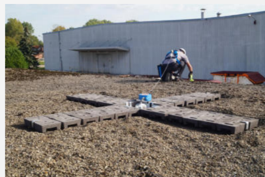
Mobifor mobiel ankerpunt met 24 losse gewichten voor op platte daken.
